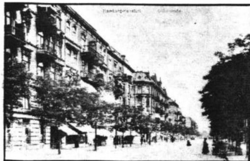
Goßlerstraße — heute Eppendorferweg — hinter der Hoheluftchaussee vor dem ersten Weltkrieg.
