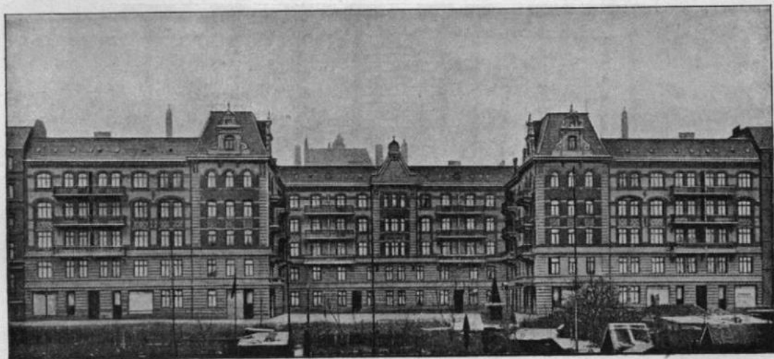
Fig. 7. Neubau des Bau- und Sparvereins in Hamburg.
